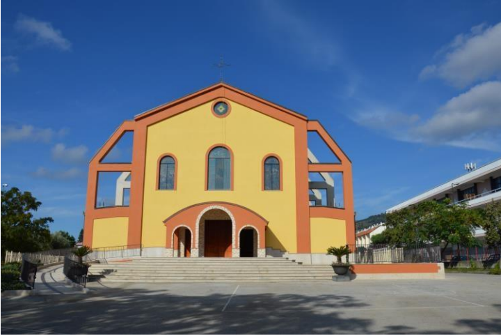
Ristrutturazione Chiesa S. Giuseppe Artigiano – Lamezia Terme
