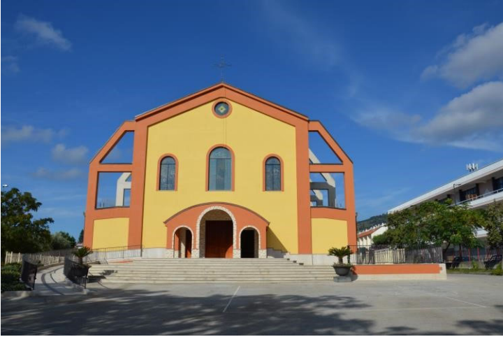
Ristrutturazione Chiesa S. Giuseppe Artigiano – Lamezia Terme
